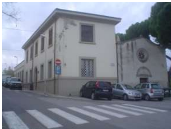
veduta del complesso (utilizzabile il piano superiore)
